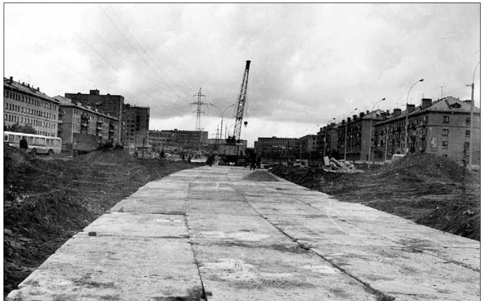
Идет строительство автомобильной дороги в начале проспекта Советских космонавтов, лето 1978 года.
