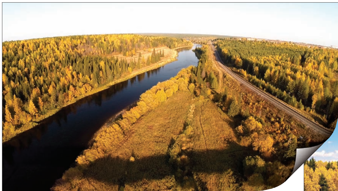
Вид над мостом по обьездной дороге Ухта – Сосногорск.
