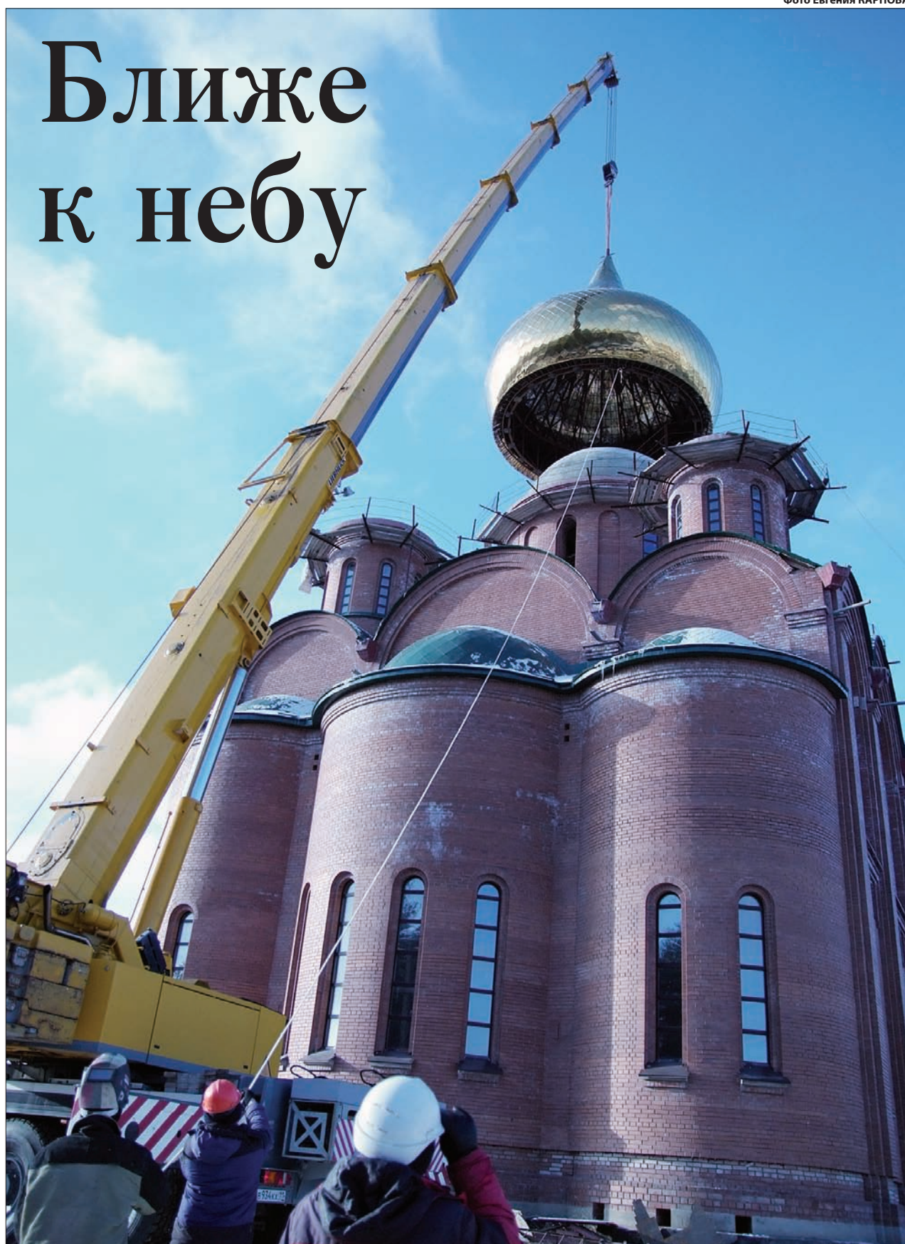
На строящемся храме по проспекту Зерюнова установили центральную главу. До конца года планируется установить пять оставшихся.
